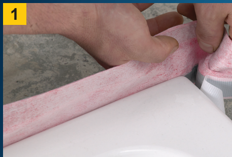
1 OHA-Easy-2-Protectband an Wannenrückseite ankleben.
